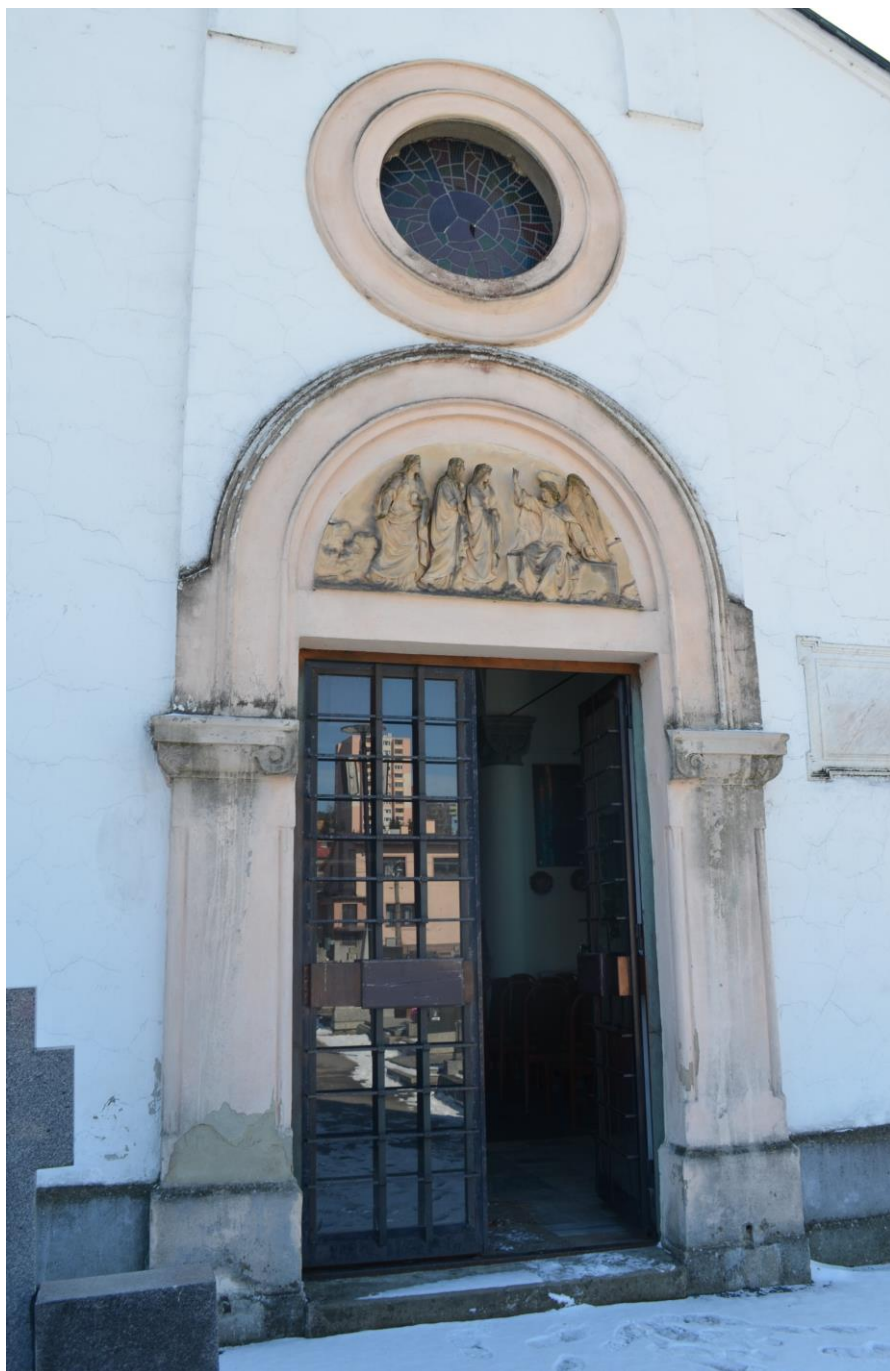
4. Pohľad na hlavný vstupný portál do Mauzólea, SZ strana (foto: Piecková, jún 2023)
