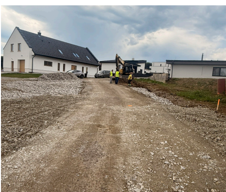
Strojárska v priebehu realizácie
