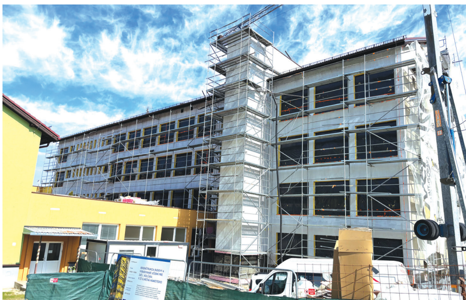
Na budove ZŠ bolo nutné prerobiť aj vonkajšiu fasádu.
