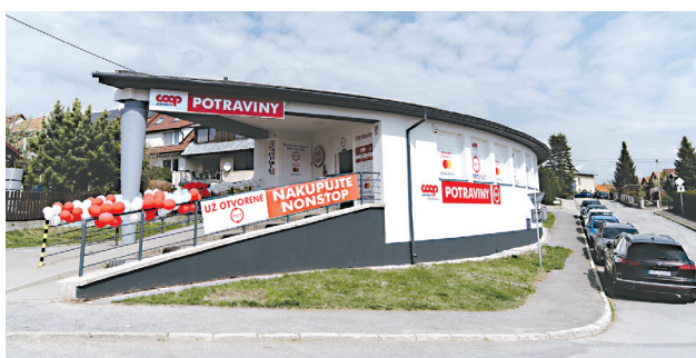
Predajňa na Čerchl'och je k dispozícii zákazníkom 24/7.
