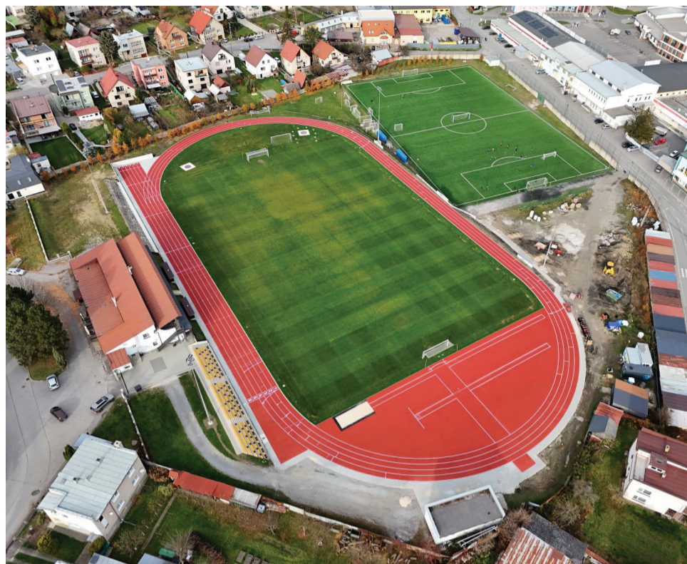
Modernizácia atletického ihriska v areáli MŠK Námestovo.
