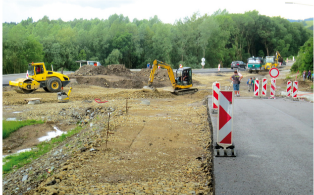
Práce na kruhovej križovatke smerom od Oravskej Jasenice sú v plnom prúde a ukončené by mali byť do konca júna.
