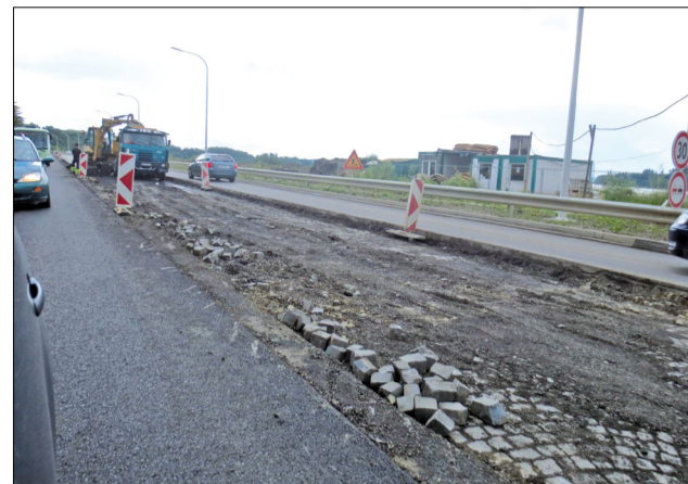
Podklad pôvodnej štátnej cesty nespĺňa súčasné normy, preto sa musí vybrať a nahradit' novým podkladom. Foto: (msú)
