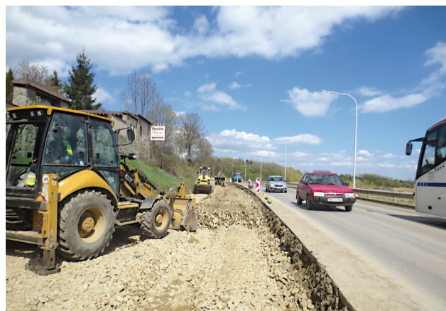
Práce na výmene a spevňovaní podkladovej vrstvy komunikácie v úseku medzi križovatkami pri Stavebninách Grigel' a kostolom. Foto: (mr)
