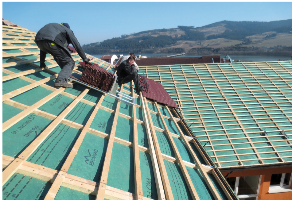
Na dvoch objektoch ZŠ Brehy bolo treba vymeniť bezmála 1500 m 2 strešnej krytiny vrátane ostatného príslušenstva strechy.
