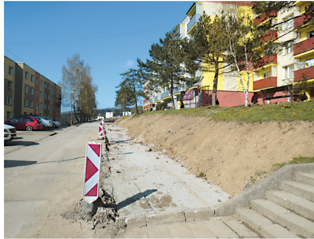
Veteernej ulice na Brehoch sa dočkala rozšírenia o 2,5 metra. Foto: (msú)
