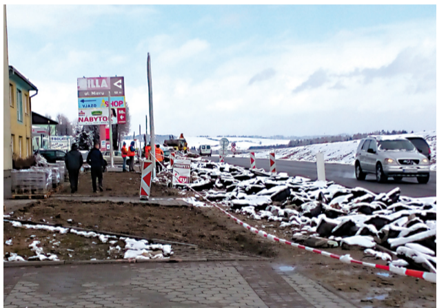
Začiatkom týždňa napadlo niekoľko centimetrov snehu a tak nepriazeň počasia stavbárom zasiahla do organizácie i výkonnú prácu.
