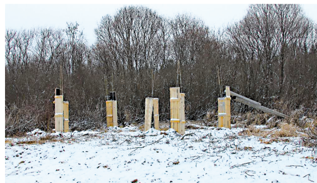
Prípravovaná výstavba nového objektu.
