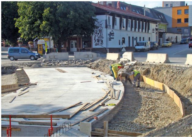
Minulotýždňový pohľad na budovanie prístupovej cesty od OD Terno.
