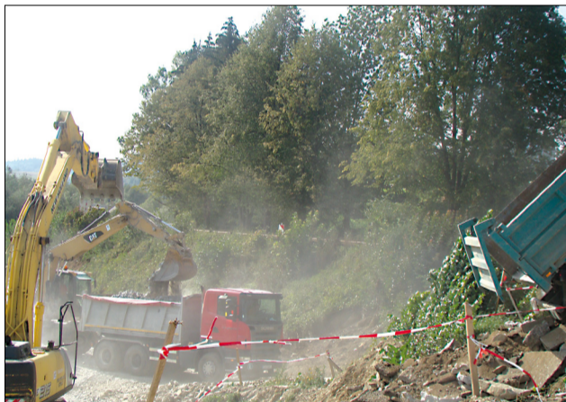
Najväčší pracovný ruch vidieť pri budovaní skalného násypu- oporného múru oproti ČSOB.
