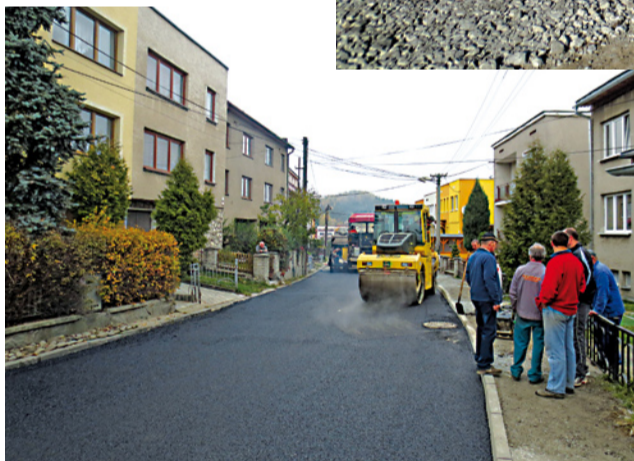
Práce asfaltérov na Sládkovičovej ulici.
