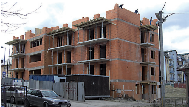
Domov pre seniorov podrástol o dve podlažia. Foto: (msú)
