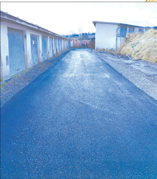
Odvodnená a vyasfaltovaná plocha po stavebných úpravách. Foto: (MsÚ)
