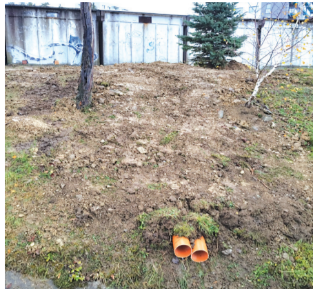
Odvodnenie sa pretlačilo popod jednu z garáží.
